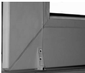
Рис.3 Установленный кронштейн без крышки
